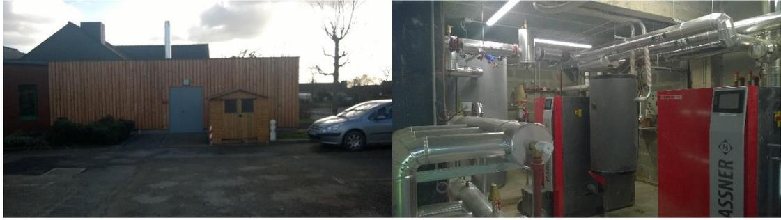
Figure 9 : Chaufferie à bois et réseau de chaleur de Baulon
